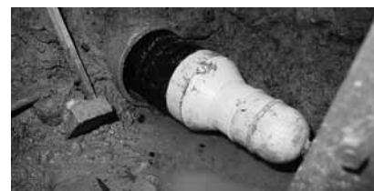
Рис. 11.2 Фотография носового конуса, приваренного стыковой сваркой
