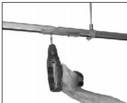
4. Присоединяется следующая монтажная шина, закручиваются 4 крепежных болта (шины не должны соприкасаться друг с другом).
