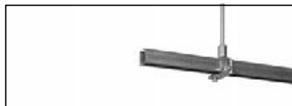
2. Монтажная шина фиксируется на подвесе.
