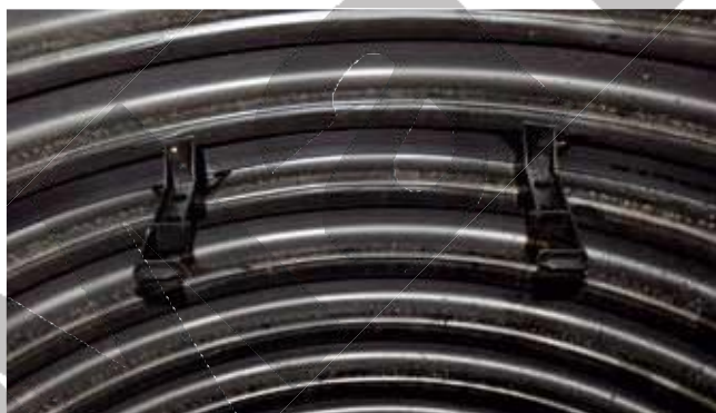
Рис. 6. Подготовка держателя лестницы в шахтной трубе.
