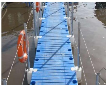
5. Типовые сходы представляют собой модуль изготовленный методом ротоформовки и специальные крепления для фиксации с модульным понтоном.
