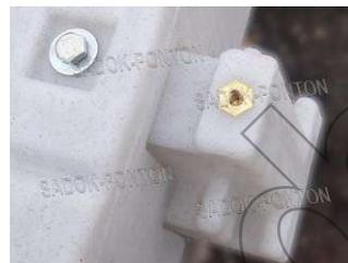
*Все болтовые соединения при сборке обрабатываются солидолом, специальной медной смазкой или аналогичным материалом.*
