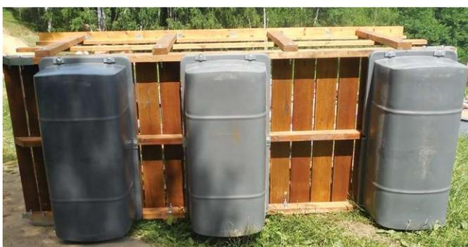
Поплавки монтируются под деревянный каркас причала (или аналогичного сооружения), изготовленного преимущественно из дерева. Количество поплавков зависит от необходимой грузоподъемности с учетом веса самой конструкции.
