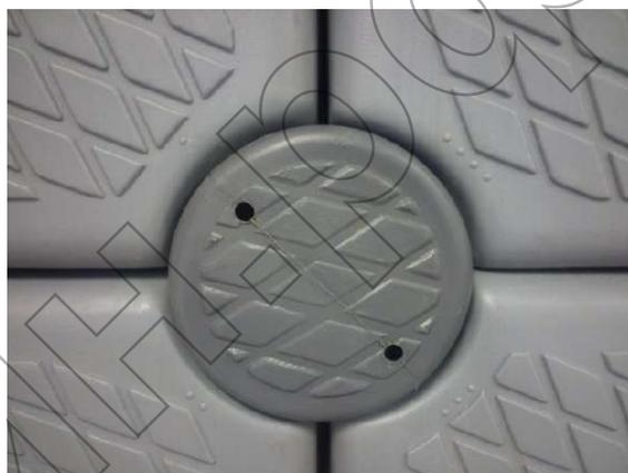
3. Далее в зависимости от назначения данного узла вставляется либо элемент соединительный со «шляпкой» в уровень с модулями. Его предназначение исключительно для соединения. Данный элемент вставляется в пазы всех четырех ушек и проворачивается на 90 градусов. Для удобства используйте два отверстия сверху.
