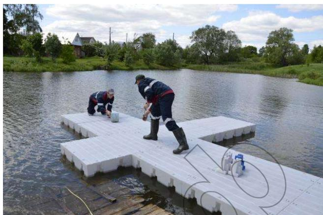
2. Элемент соединения (крепеж) модулей вставляется одним концом в первый модуль и затягивается болтом М10 с шайбами. **Ключ на 17.** Следующий модуль надевается сверху на выступающие части элементов соединительных и закрепляется с помощью болтов с гайками.
