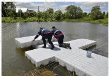
3. В зависимости от назначения рым-гайка M10 (рым-болт) устанавливается ушком вверх или вниз. Ключ на 17. Вариант вниз – для якоря, вариант вверх – для растяжки тросами или крепления лодок.
