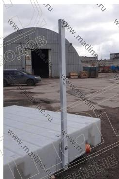
5. Леерная стойка устанавливается на боковой элемент и прикручивается болтом M10 с гайками. Для монтажа потребуется ключ с накидной гайкой на 17.
