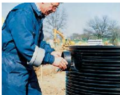
2. В выполненном отверстии монтируется уплотнитель муфты in situ. Он смазывается силиконовой смазкой, что позволяет установить в ней раструб in situ.
