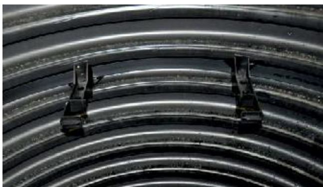
Рис. 6. Предварительный монтаж держателя лестницы в шахтной трубе.
