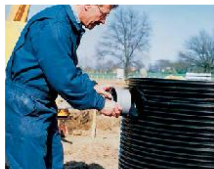
3. Таким образом установленная муфта in situ готова для размещения в ней канализационной гладкостенной трубы ПВХ.
