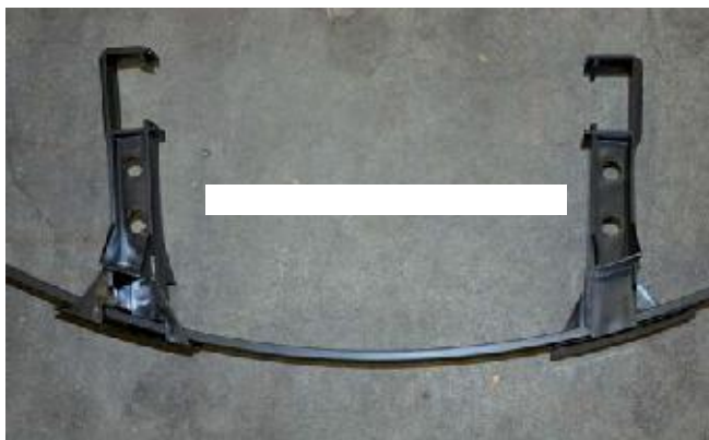
Рис. 4. Деталь – расположение кронштейнов лестницы на ленте.
