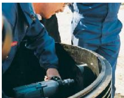
1. Специальной фрезой выполняется отверстие в гофрированной трубе, а затем его края зачищаются от заусенцов.
