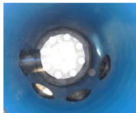
KGZ-MPM D1200 H2000: гидрозатвор на выходе
