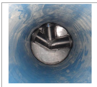
2 входа d200 в лоток с выходом d200
