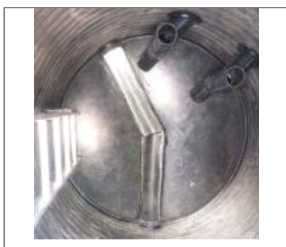
2 входа d110 в лоток с выходом d160
