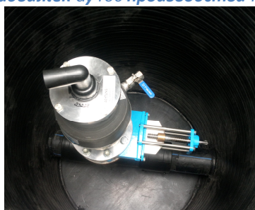
Колодец с предустановленным вентузом и задвижкой Hawle
