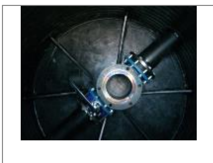
Подставка под гидрант тип ППФ с задвижкой
