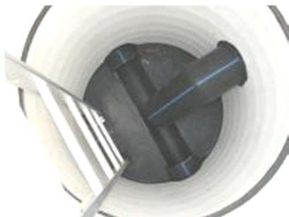
Трубный гаситель потока и лестница сделанные в соответствии с проектом
