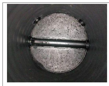
Прямопроходной лоток d110 с врезками d110 выше лотка.
