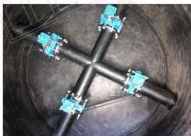
Колодец диаметр 2000 с размещением 4-х задвижек *du150* производства Hawle
