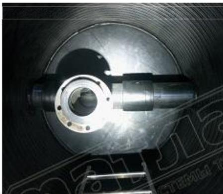
Колодец ВК-МПМ для напорной канализации с предустановленным оффланцовым тройником ревизии. Крышка – глухой фланец.
