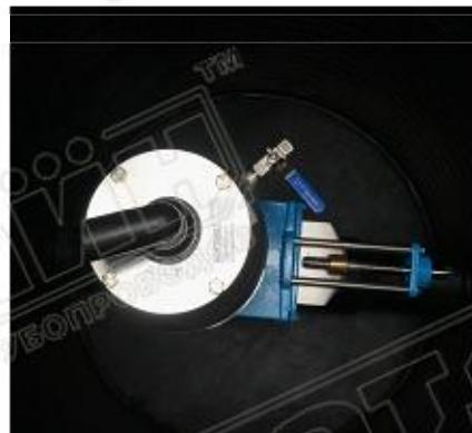
Колодец ВК-МПМ для напорной канализации с предустановленными задвижкой и вантузом
