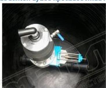
Колодец с предустановленным вентузом и задвижкой Hawle
