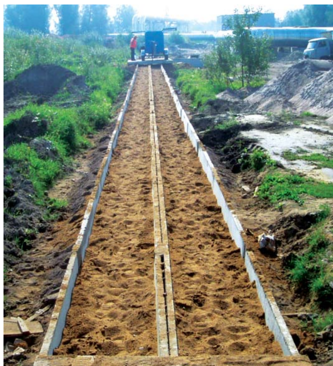
Рис. 6. Прокладка КЛ в железобетонных лотках. 2КЛ-110 кВ ПС «Северная», ПС «Лахта», Санкт-Петербург
