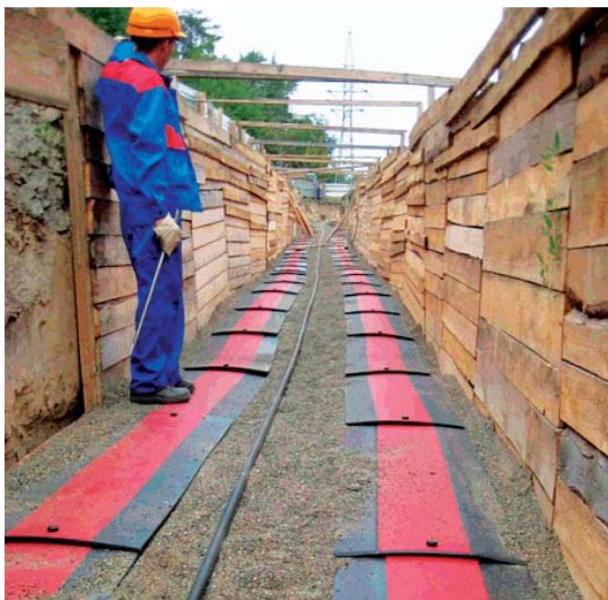
Цепи 2КЛ-110 кВ сверху закрыты полимерными защитно-сигнальными листами
