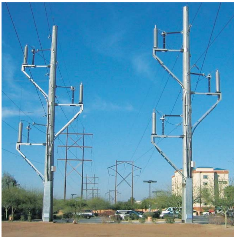
Рис. 9. Переходные пункты на опорах ВЛ
