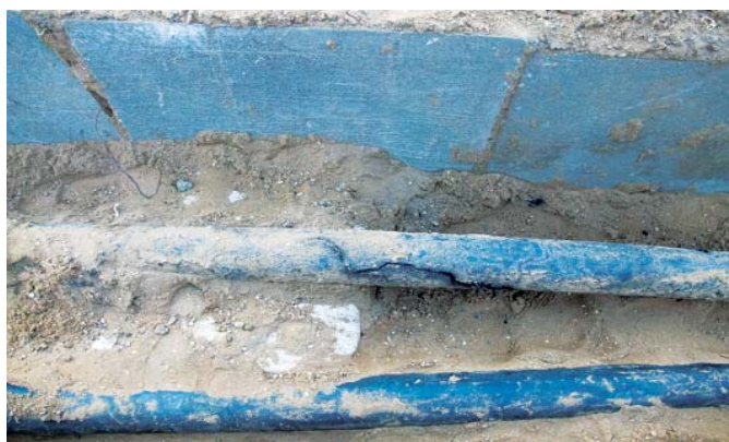
Цепи 2КЛ-110 кВ сверху закрыты полимерными защитно-сигнальными листами
