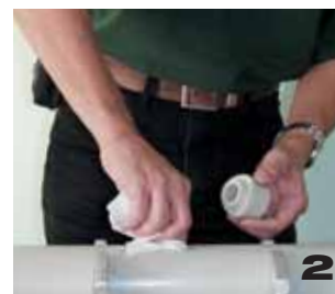
2 Зачистить. Если применяется трубка Stabi, то у высверленного отверстия скосить фаску. Очистить и обезжирить фасонную часть и высверленное отверстие.
