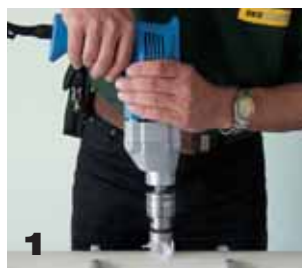
1 Специальной фрезой высверлить отверстие для седла
