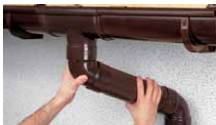
Рис. 19 Монтаж стояка с отводами и трубой
