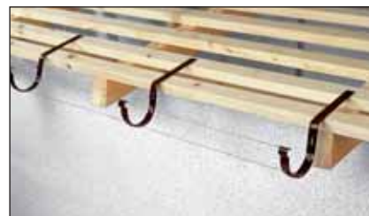
Рис. 2 Кронштейны с развёрнутым креплением
