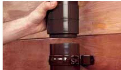
Рис. 20 Монтаж водосточной трубы при помощи муфты
