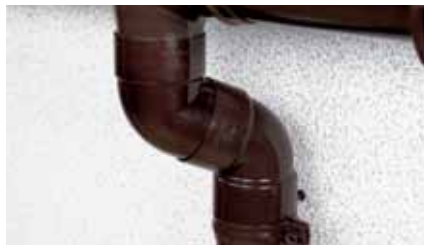
Рис. 18 Стояк с двумя отводами
