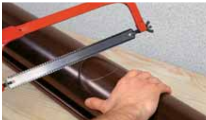
Рис. 14 Монтаж углов желоба
