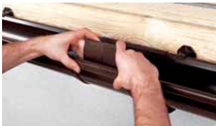
Рис. 12 Вырезание отверстия под воронку
