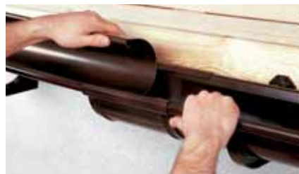
Рис. 11 Разметка места под воронку
