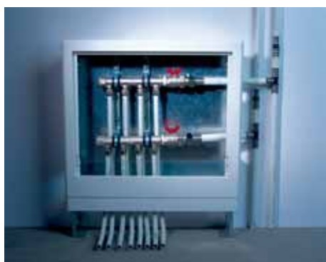
Подводка трубы к коллекторам
