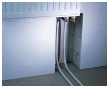
Непосредственное подключение трубы к радиатору
