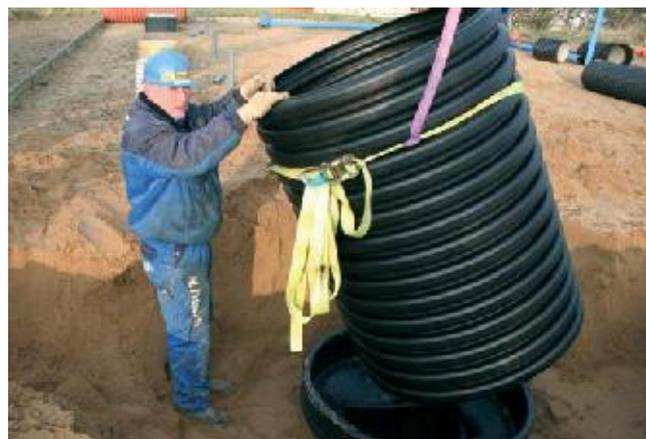
Расположение уплотнительных колец и места подрезки трубы для разных вариантов показаны выше. Раструб лотковой части смазать соответствующим антифрикционным средством, после чего выполнить соединение шахтной трубы с лотковой частью. При установке шахтную трубу следует удерживать в положении, перпендикулярном лотковой части.
