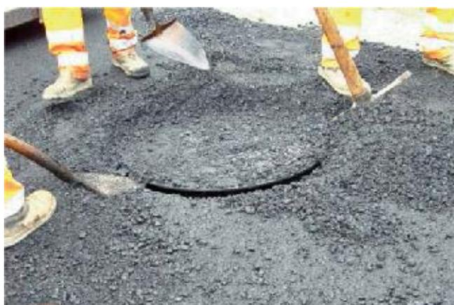
13. В случае установки люка на телескопическом адаптере повторить уже ранее выполненные действия или поднять люк, так чтобы он находился на высоте мин. 20% толщины слоя выше, чем уплотнённый битумный слой.
