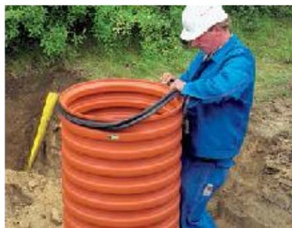
5. Установить уплотнитель для гофрированной трубы с внешней стороны шахтной трубы, в углублении между первой и второй гофрой трубы.
