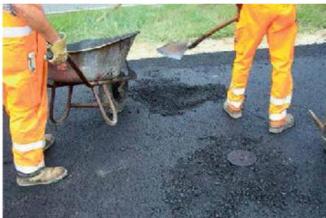
10. Заполнить пространство под люком /телескопическим адаптером массой, используя деревянные скрепки. Позаботьтесь, чтобы тщательно заполнить все пустые места. В случае необходимости дополнить объём битумной массой. Материал возле рамы люка уплотнится во время уплотнения и укатки следующего слоя покрытия.
