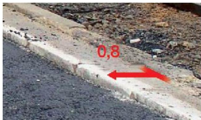
2. На обочине или тротуаре обозначить положение колодца, так чтобы после укладки слоев дороги, колодец можно было найти.
