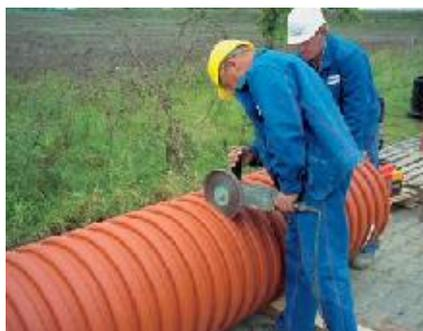
4. Обрезать шахтную трубу до требуемой высоты ручной или механической пилой. Необходимо помнить, что разрезание производится посередине гофры. Так обрезанная труба правильно устанавливается вместе с уплотнителем в раструбе шахтной трубы.
