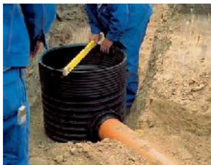
2. Днища устанавливаются на стабильной выровненной почве и 5-10-сантиметровой неуплотненной подсыпке из песка. Днища колодцев Тегга с двойным дном требуют локального 10-сантиметрового заглубления по отношению к траншее для канализационного трубопровода. В таком образом приготовленной почве установить днище. Верх днища необходимо выровнять.
