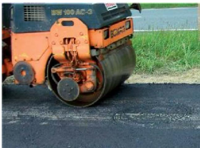
15. Тщательно почистить люк и закатать в одной плоскости с укладываемым асфальтом, без вибраций. После окончания работ необходимо удалить с люка остатки асфальта.
