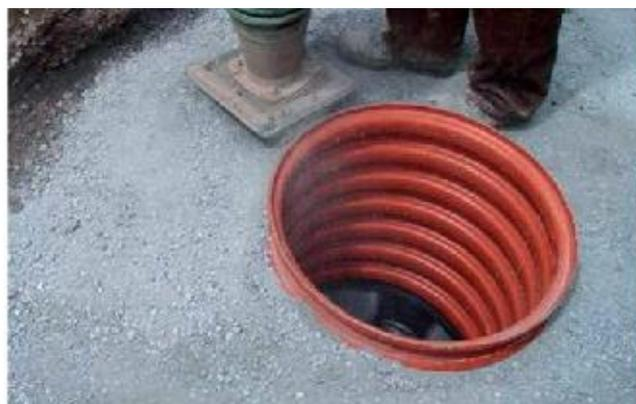
1. Тщательно уплотнить грунт вокруг колодца, начиная от самого его дна. Уплотнение проводить слоями не больше, чем 30 см, придерживаясь при этом инструкции по монтажу колодцев. Защитить обсыпку колодца перед вымытием согласно нормам PN-EN 1010 и PN-ENV 1046. Установить верхний край колодца ок. 35 см под планируемым уровнем дорожной поверхности (на уровне верхнего морозостойкого слоя).
