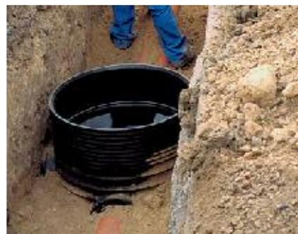
3. Подключить канализационные трубы к днищу путем вдавливания их в раструб – в патрубках с регулируемыми раструбами (диапазон кругового регулирования +/-7,5° на каждом из патрубков). Используемый диапазон регулировки по мере возможностей равномерно распределить на входной и выходной патрубки. Для того, чтобы обездвигнуть соединенный канализационный узел, рекомендуется засыпка траншеи до высоты как минимум 10 см выше трубы. Соединительный раструб к шахтной трубе остается выше обсыпки.
