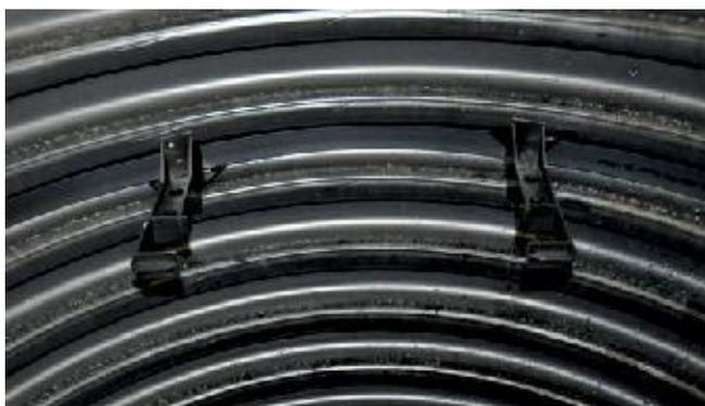
Рис. 6. Предварительный монтаж держателя лестницы в шахтной трубе.
