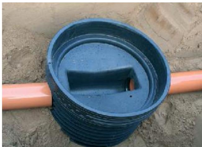
**ВНИМАНИЕ!** Котлован для установки колодца должен быть глубже, чем траншея для укладки труб системы.
