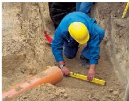
1. Инспекционные колодцы из-за размеров можно устанавливать в траншею с шириной, адаптированной к диаметру трубы – без местного расширения. Небольшой вес отдельных элементов делает возможным монтаж силами одного человека.
