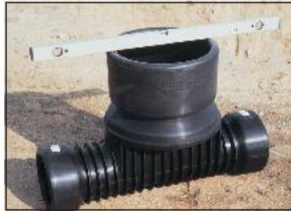
4.2 Установите днище на подстильный слой толщиной 10 см, как предусмотрено стандартом DS 430. Если верхний край раструба расположен горизонтально, внутри камеры имеется уклон 15 %.
