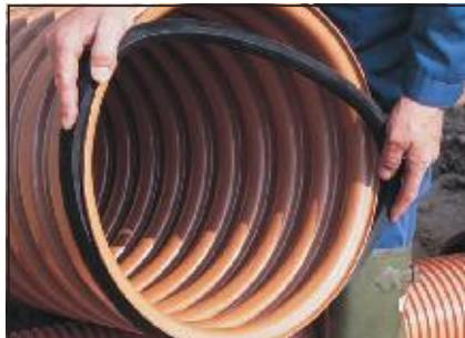
4.4 Наденьте резиновое уплотнительное кольцо на шахтную трубу (установите в нижнюю «канавку»). Труба готова к соединению с днищем колодца.
