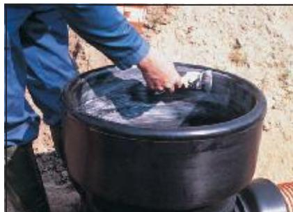
4.5 Снимите с днища колодца крышку. Нанесите смазку на конец шахтной трубы и резиновое кольцо.
