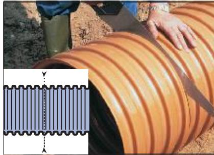
4.3 Отрежьте ручной пилой отрезок гофрированной шахтной трубы нужной длины. Пилите посередине выступающего гофра.
