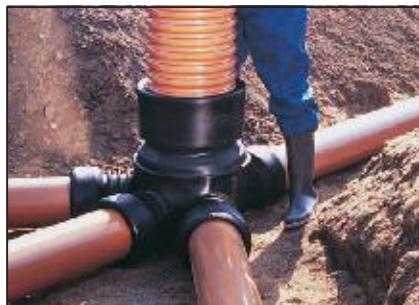
4.6 Выполните соединение, вдавив гофрированную трубу в основание колодца. Крышкой, снятой с основания колодца, закройте верхний конец шахтной трубы. В результате получается герметичное и податливое соединение шахтной трубы с основанием колодца.
